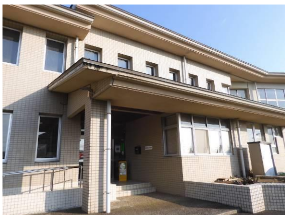
銚子市地域交流センターの外観
