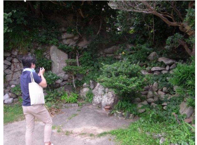
《崩落した上村古墳の石材》
